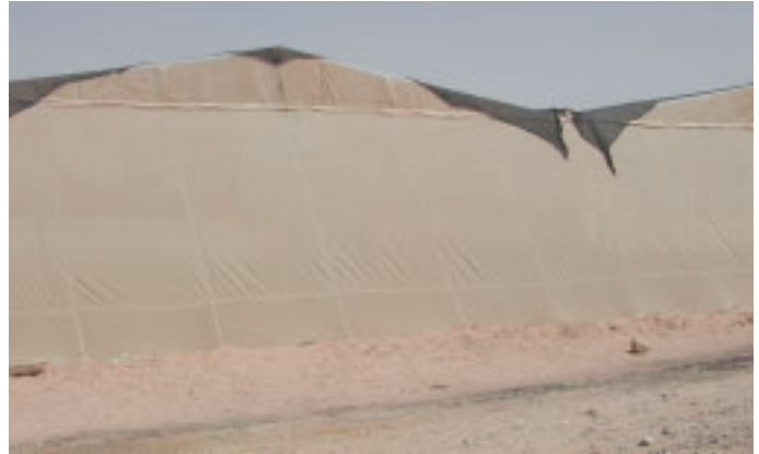
ハウスは湿度除去のために5度傾斜をつけて立てられている（ヤハブ農家）
