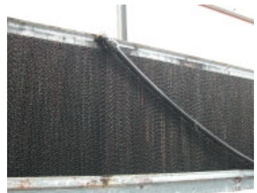
ラジエータ式の冷房装置。日本にも一部入っている
