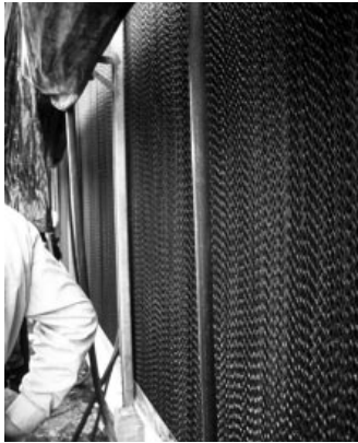
スプレー菊農家の冷房用バットアンドフィン（古川正樹氏撮影）
