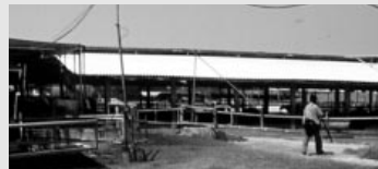
パイプ式スルーゲートと少しでも涼しくなるよう工夫されている畜舎
